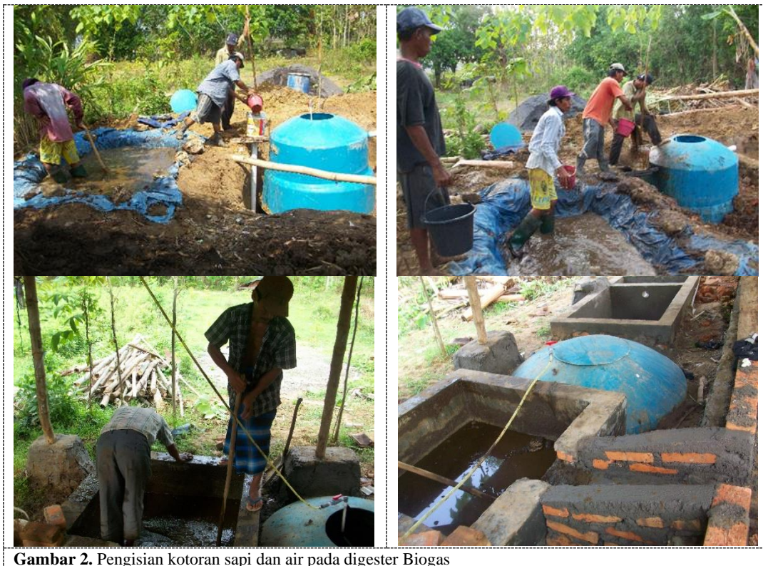
Gambar 2. Pengisian kotoran sapi dan air pada digester Biogas
